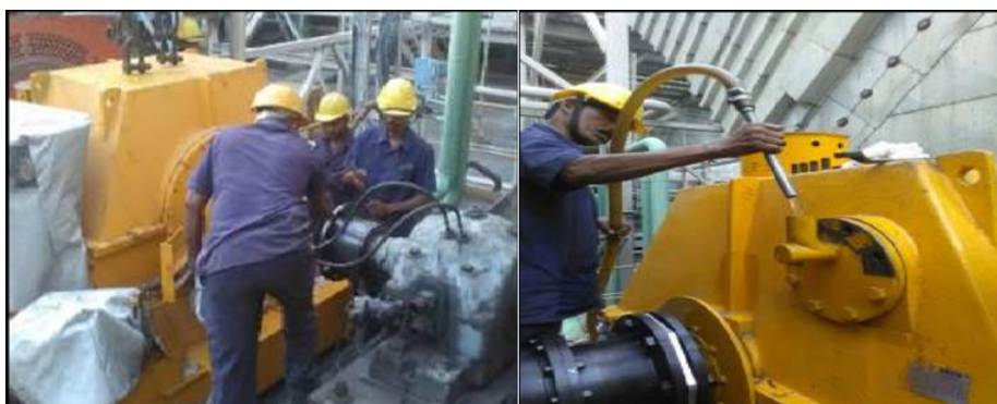
Слева – стыковка валов гидромуфты и вентилятора, справа – заливка масла в гидромуфту
